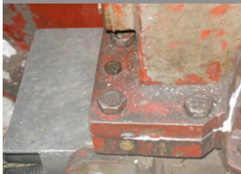
Une tôle en inox protège désormais câbles et connexions des capteurs de vitesse des turbopompes alimentaires
